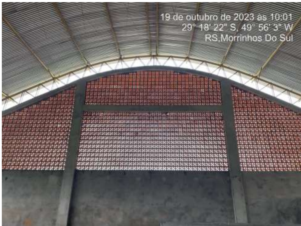
Figura 13: Elementos vazados divergentes.
