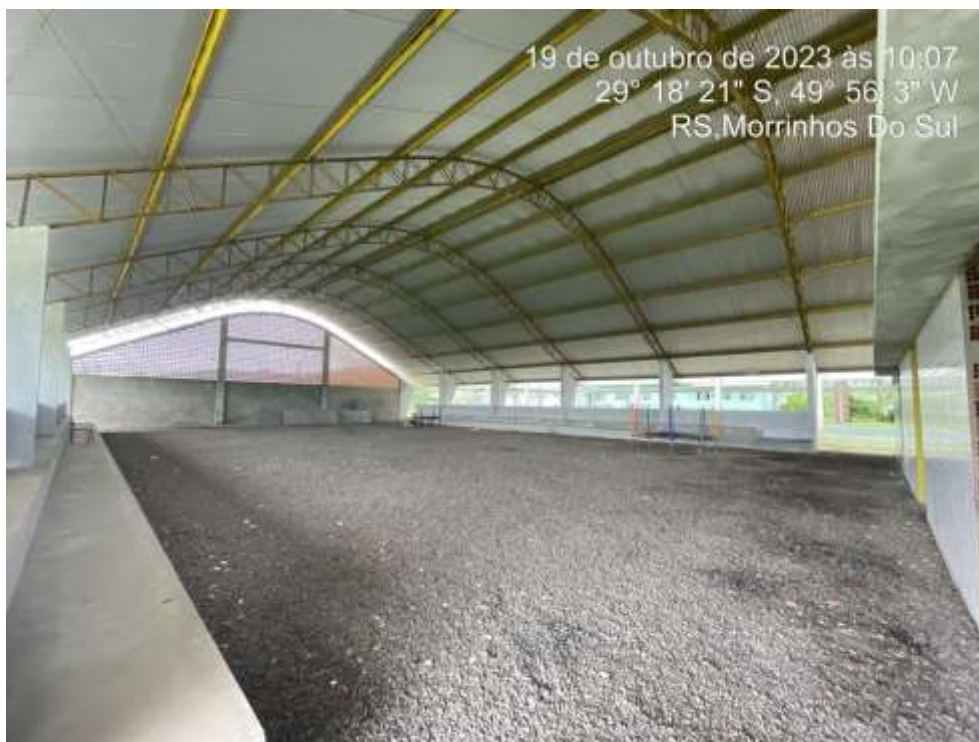
Figura 28: Piso da quadra com lastro de brita.
