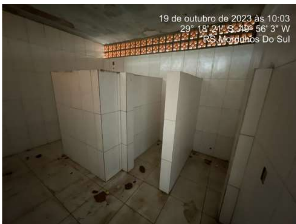
Figura 22: Vãos para a instalação das portas.
