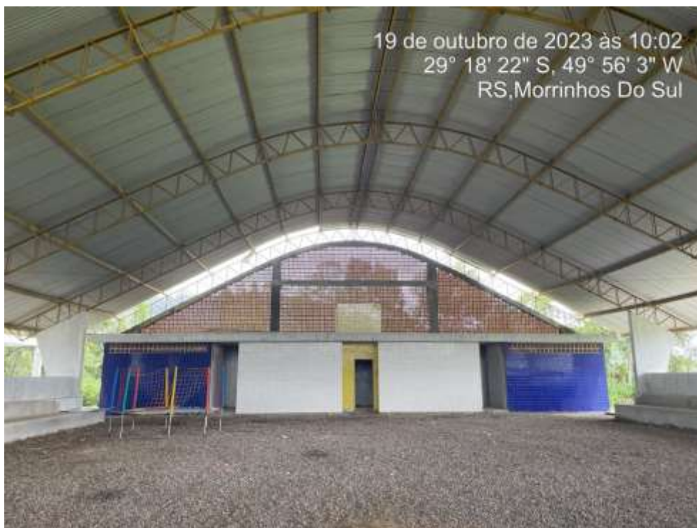
Figura 27: Revestimento cerâmico no exterior dos banheiros e vestiários.
