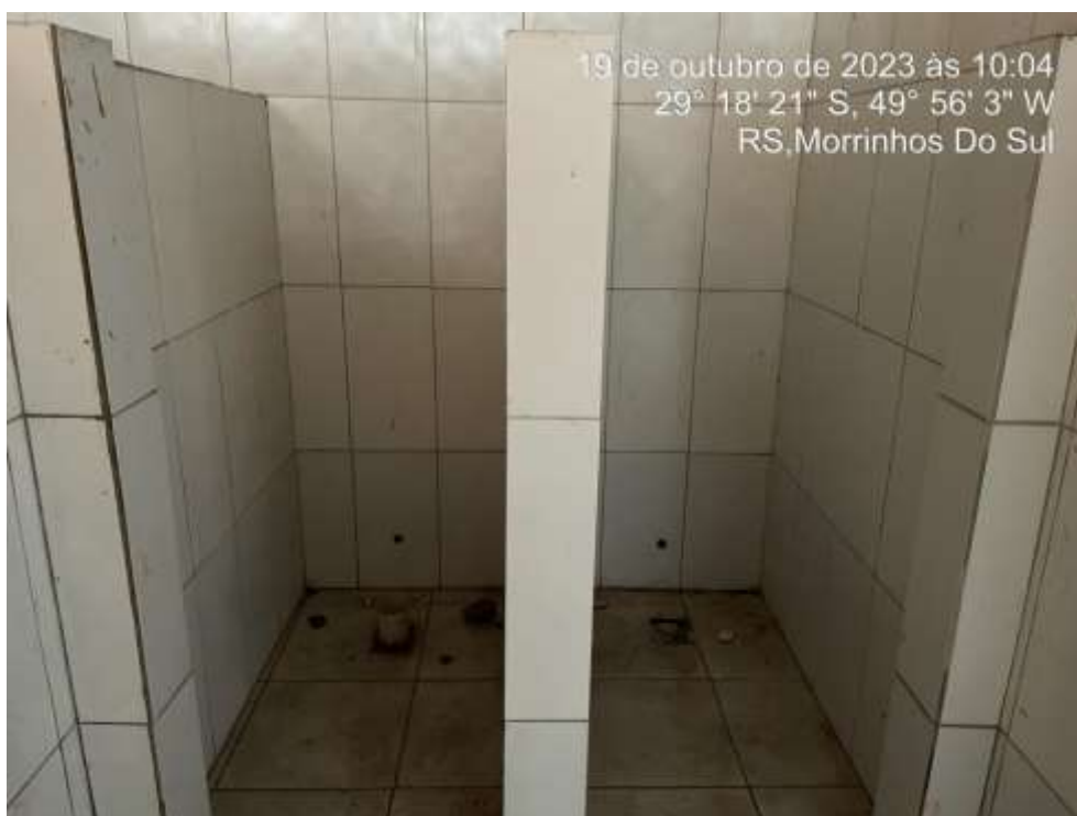
Figura 26: Revestimento cerâmico no interior dos banheiros.
