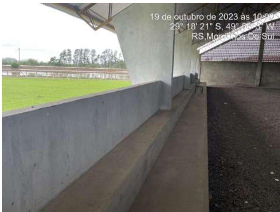
Figura 30: Paredes com selador acrílico.
