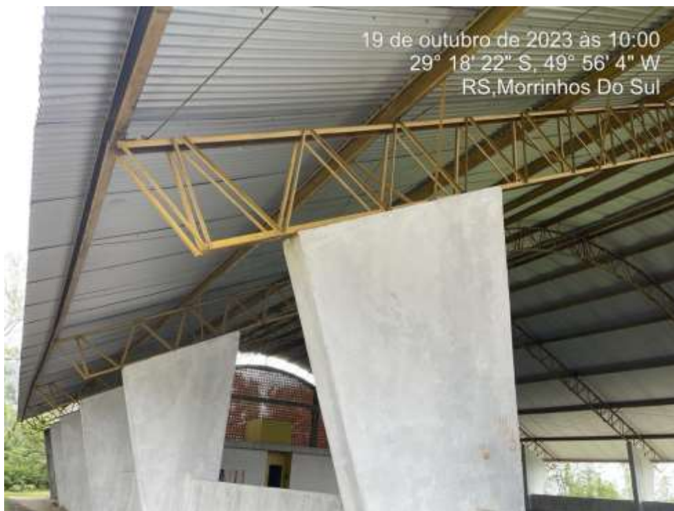
Figura 29: Pintura da estrutura do telhado
