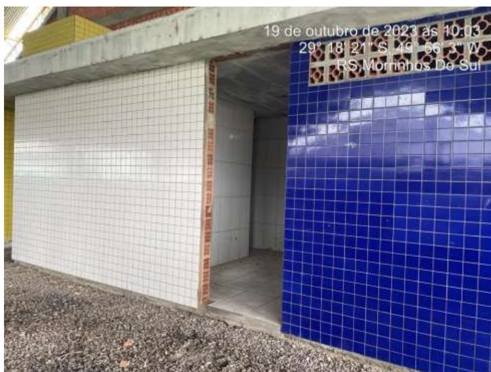
Figura 21: Vãos para a instalação das portas.
