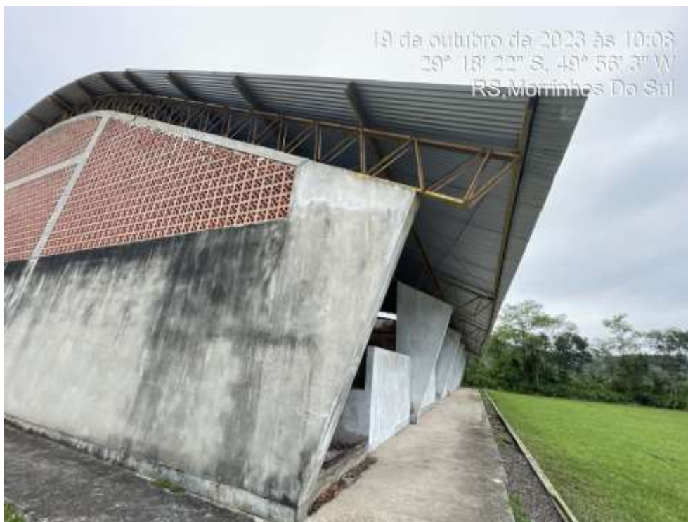
Figura 7: Exterior da quadra mostrando a Superestrutura da obra.
