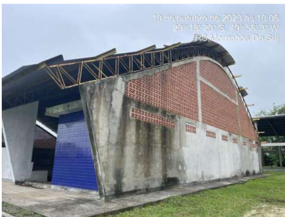
Figura 6: Exterior da quadra mostrando a Superestrutura da obra.
